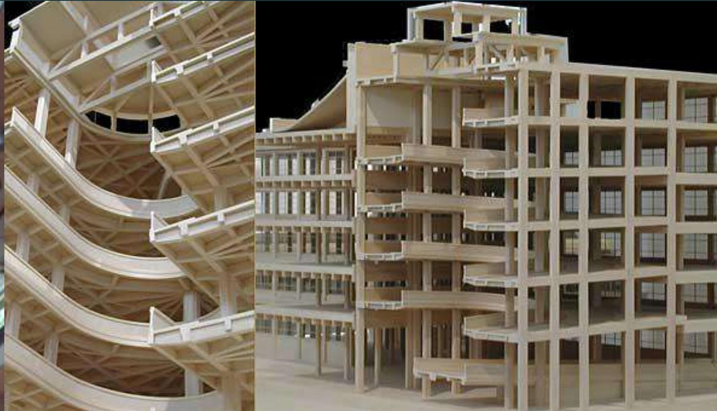
**Struttura in cemento armato impostata su una maglia di pilastri di 6x6 m, con rampe elicoidali per l'accesso ai piani superiori (utili per installazione grandi attrezzature)**
