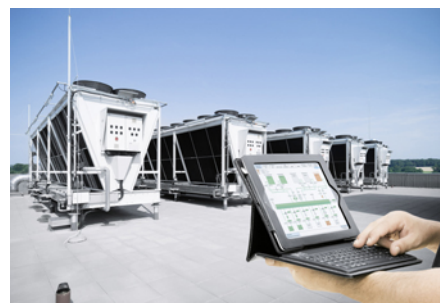
Edifici in Energy Network e efficienza in produzione
