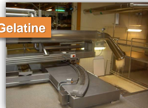
Impianti di refrigerazione ed estrusione di gelatina
