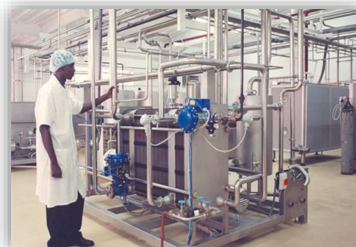
Impianti di pastorizzazione
