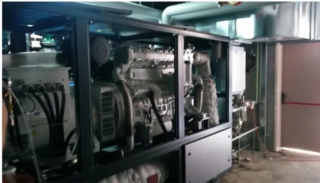
Impianto di Cogenerazione a Gas Metano per preriscaldare il reintegro di acqua demineralizzata di alimentazione della Centrale di Vapore
